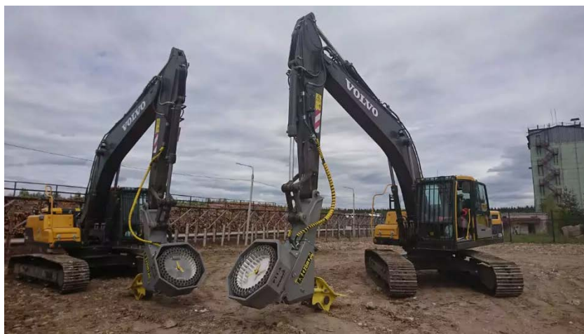
Рис. 3. Посадочный агрегат Bracke P11, установленный на экскаваторе Volvo
